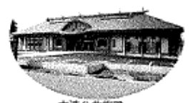
木造公共施設
